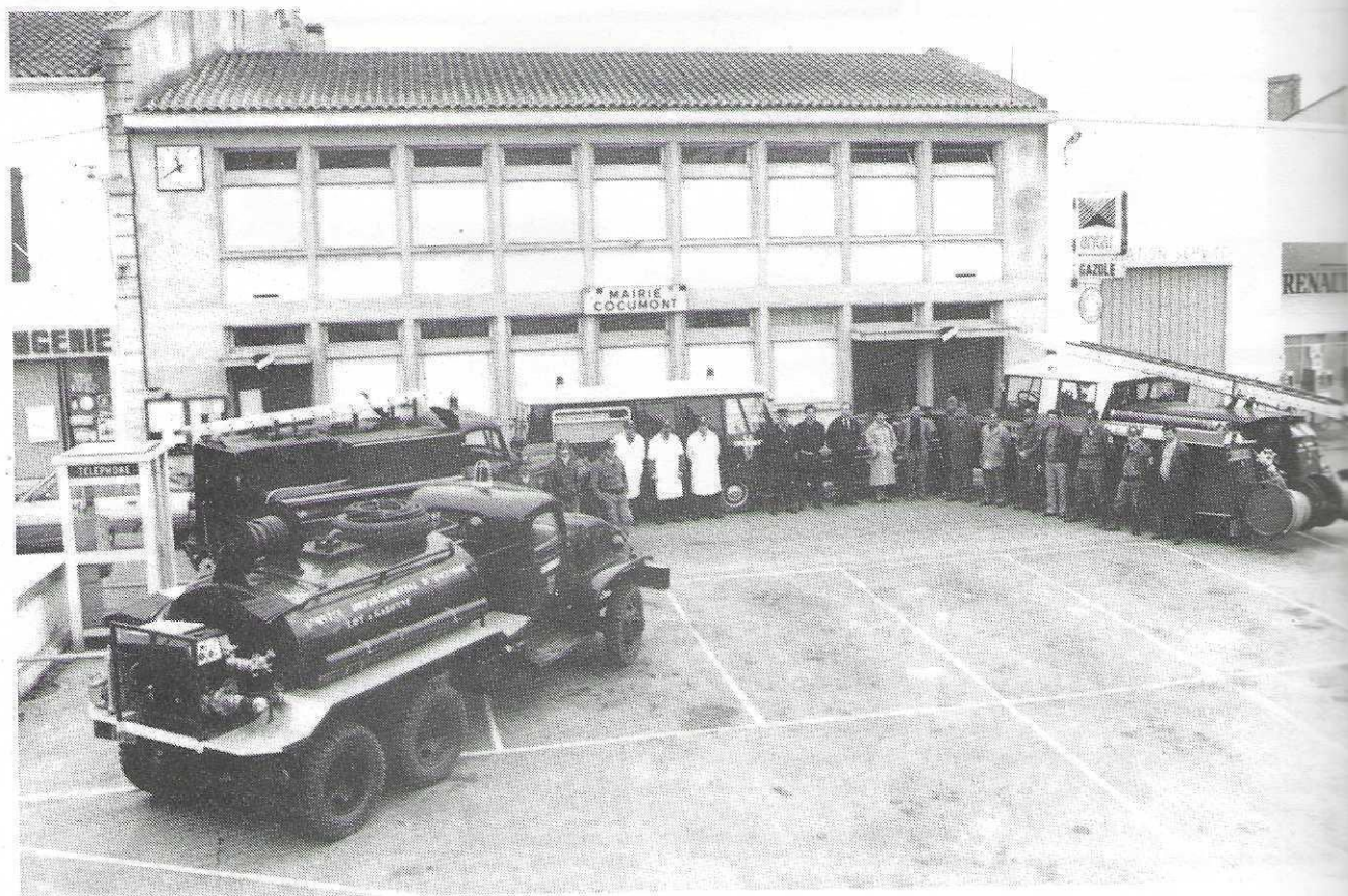
Le Personnel et le matériel du Centre de Secours de Cocumont.
